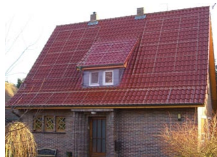
Bild 2: Dachfläche mit markierten Dach-, Modul- und Störfächen
