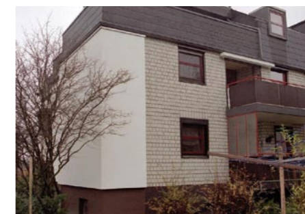
Abb. 7: Ansicht des Gebäudes nach der "Sanierung" mit Teildämmung an der Aussenecke
