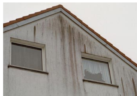
Verschmutzung bei WDVS, weil Dachüberstand fehlt
