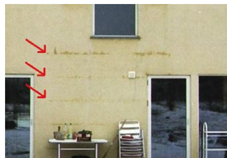
Durchfeuchtungen des WDVS durch fehlerhaft eingebaute Fenstersohlbänke
