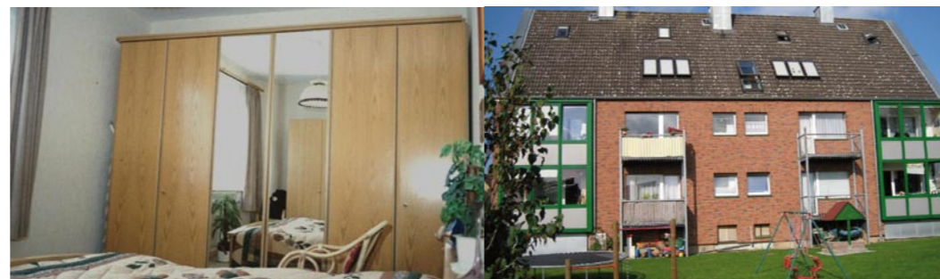
Abb. 1: Ein Schrank dicht vor der Außenwand führt im Altbau mit niedrigem Dämmniveau häufig zu Schimmelverflechtungen, weil die Wand nicht ausreichend erwärmt und belüftet ist. Hier helfen nur große Abstände zwischen Wand und Schrank, andere Möbel oder ein verbesserter Wärmeschutz
