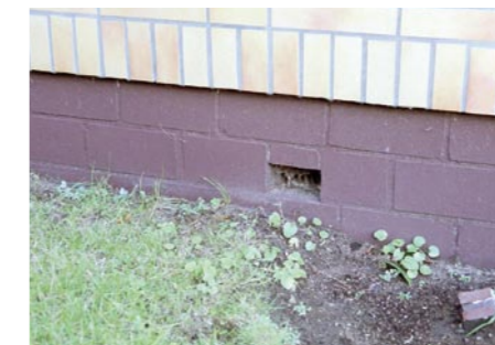
Abb. 3: Nach der Sanierung wurde "Fußkälte" beanstandet. Der Fußboden ist ungedämmt, unterlüftet und das WDVS nicht tief genug heruntergeführt.
