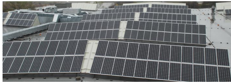
Bild 1: Nicht jedes Modul gleicht dem Anderem. Alle weisen unterschiedliche Werte auf. Anfänglich i. d. R. +/- 3 % Toleranz
