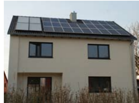
Fassadensanierung und Installation einer Solar- und Photovoltaik-Anlage (nachher)
