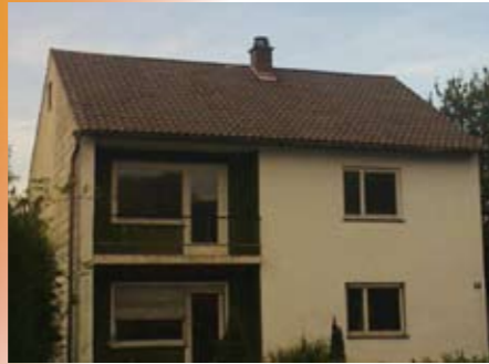
Fassadensanierung und Installation einer Solar- und Photovoltaik-Anlage (vorher)
